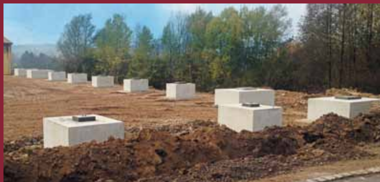
Fundamente für Hallen
