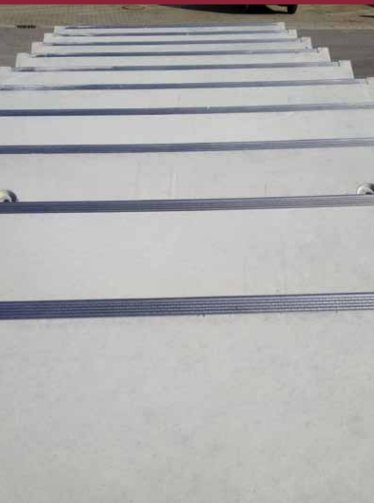
Faltwerktreppe mit Edelstahlkanten
