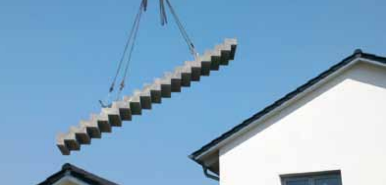
Faltwerktreppe in Sichtbeton
