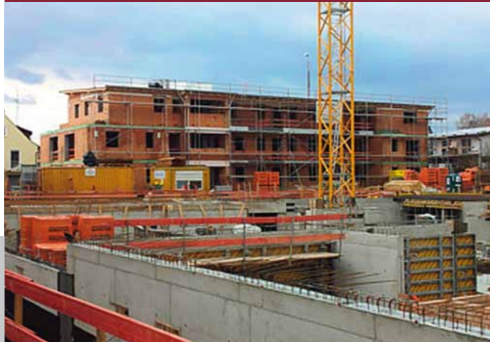
Wohnanlage mit 57 Wohneinheiten bei Landshut
