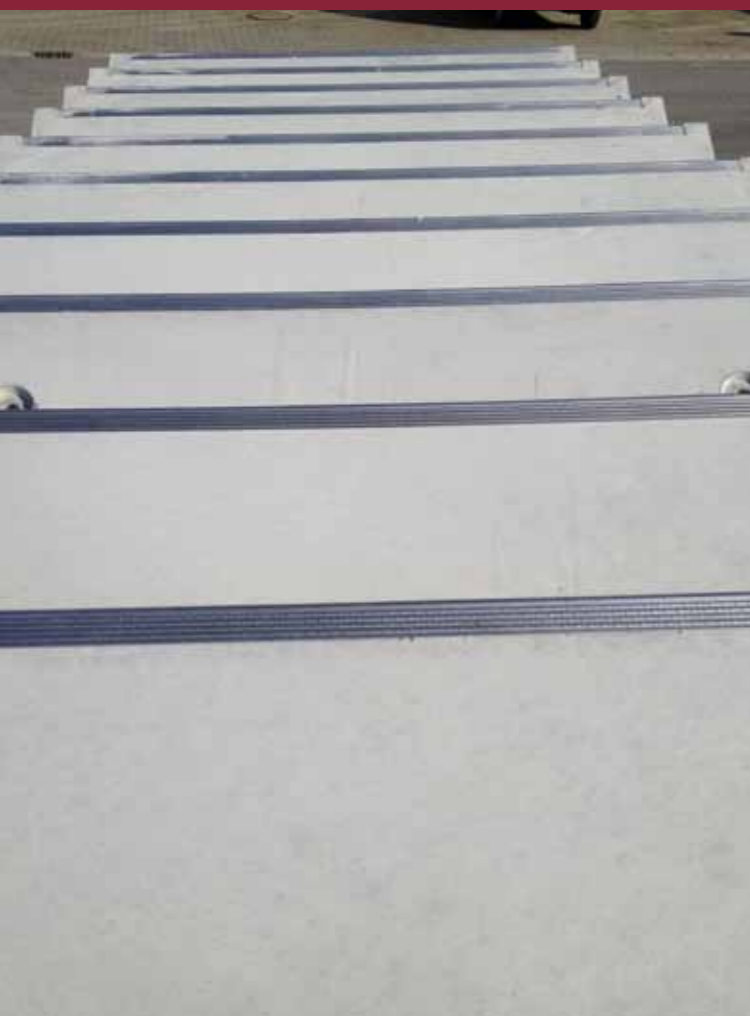
Faltwerkterrasse mit Edelstahlkanten
