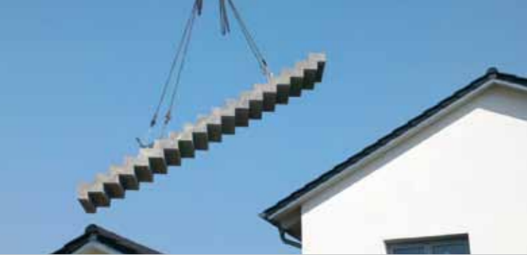
Faltwerkterrasse in Sichtbeton
