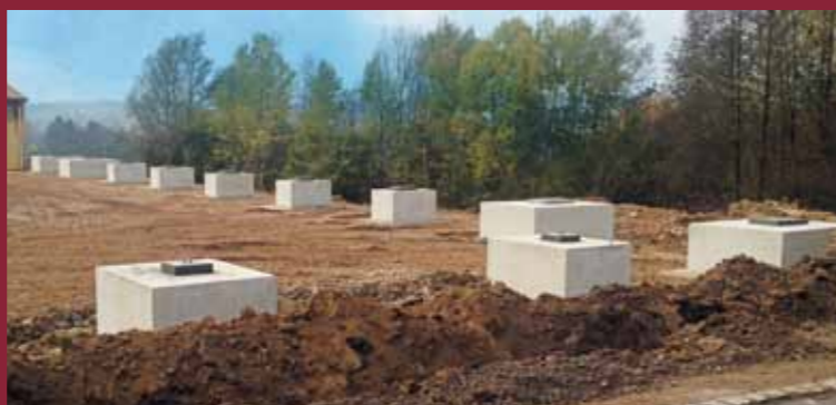
Fundamente für Hallen
